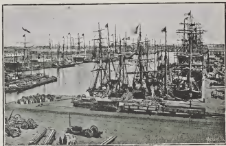
Nouveau Bassin du Kattedyk.
